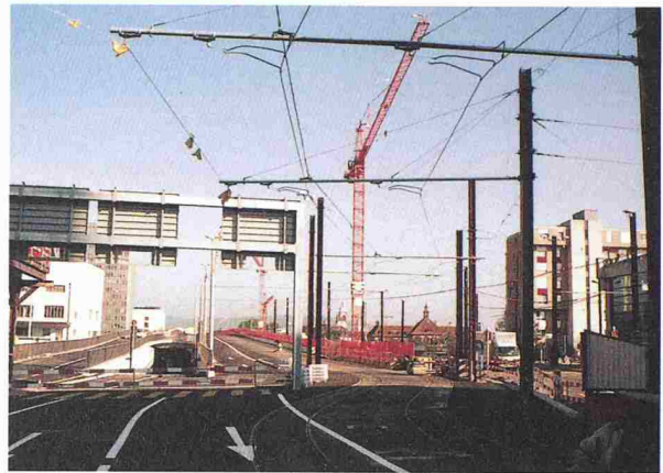
Die Teilnehmer der ersten Berufsgruppentagung konnten sich im Raum Basel auf drei Grossbaustellen – unser Bild zeigt die Baustelle Dreirosenbrücke – von den Massnahmen zur Begrenzung der Umwelteinflüsse ein Bild machen (Bild: pps)
