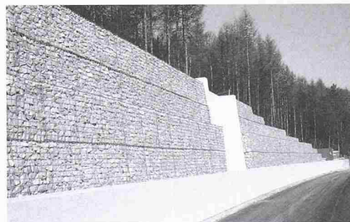
Böschung- sicherung am Baregg A1
