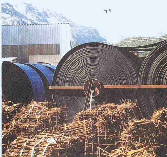
Das Baumaterial- und Ersatzteillager bei der Baustelle Mitholz lässt den Umfang der Bauarbeiten erahnen.
