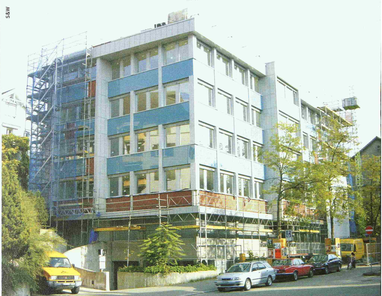
Geschäftshaus Hänggerstrasse, Zürich
