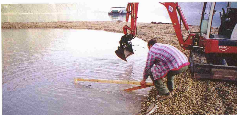
Die Ringinsel im Bau (Bild: P. Regli)
