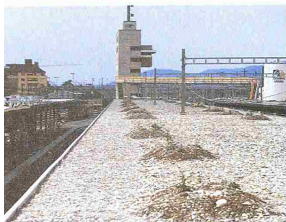
Reliefartige Dachbegrünung im HB Zürich
