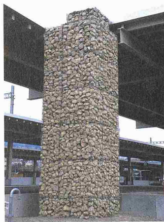
Säule aus Steinkörben als vertikaler Verbindungssteg zwischen Erdboden und Dach
