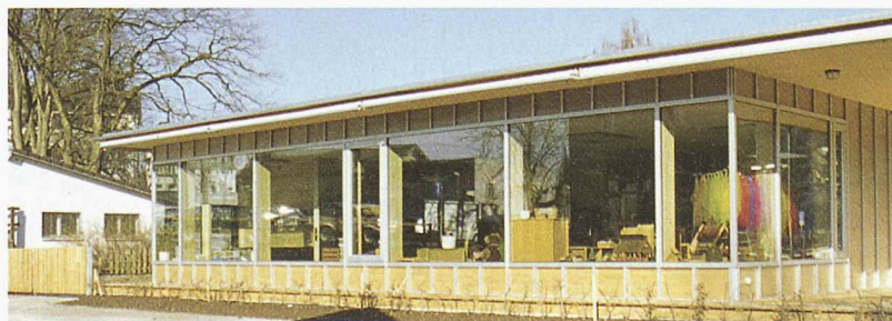
Der Kindergarten in Wil SG ist ein Passivhaus aus Holz (Architektur: Grob und Schöpfer)
