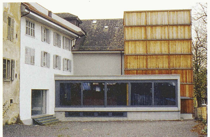
Erweiterung des Stadttheaters von 1925 durch Baumann und Rigling: Das mit Holz verkleidete Bühnenhaus erinnert an frühere hölzerne Anbauten an die Stadtmauer (Bilder: SHS)
