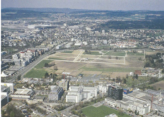
Hat die Raumplanung rund um den Flughafen versagt? Planungsgebiet Oberhauserriet, im Hintergrund links der Flughafen (Bild: Comet)
