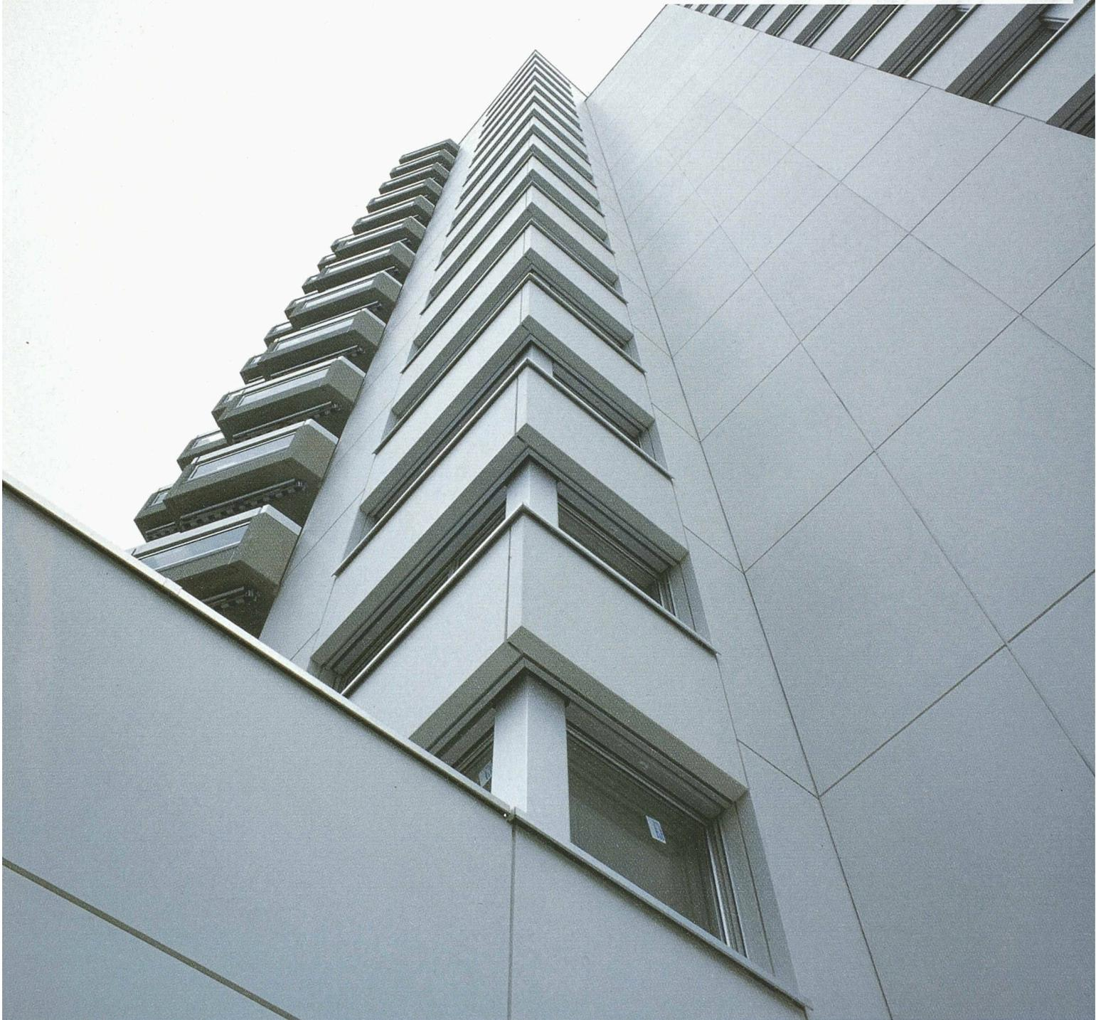
CEMFOR® Fassadenelemente 16mm - Elementgroup MSF
