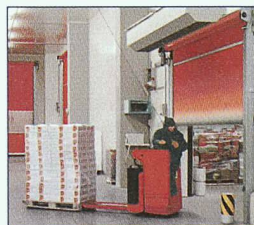
Schnelllaufwerke mit flexiblem Behang für Innen und Aussen
