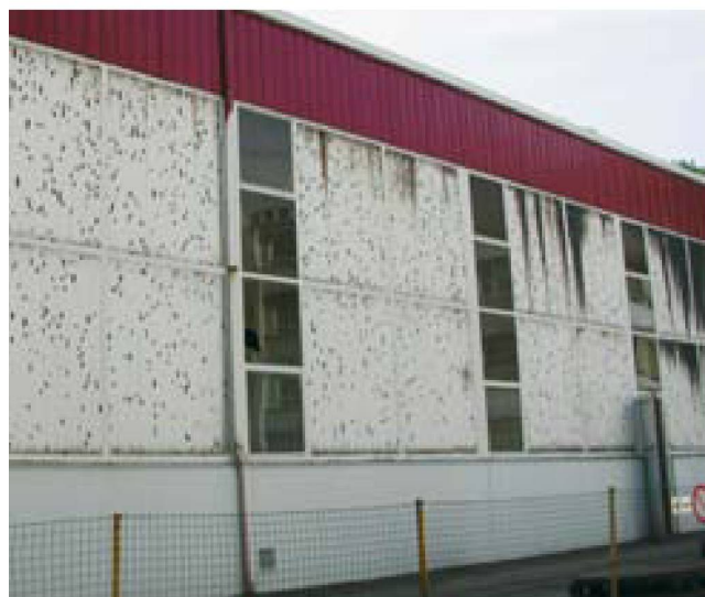
Folgen des Hagelgewitters vom 24.6.2002 an einem Werkstattgebäude (Bild: Gebäudeversicherung Kanton Zürich)
