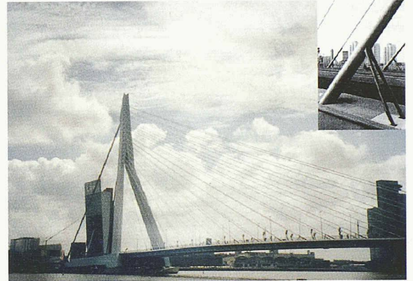
Typisches Beispiel einer Schrägseilbrücke: Erasmus-Brücke in Rotterdam. Oben rechts sind die viskosen Dämpfer abgebildet, die zur Minderung der Kabelschwingungen installiert wurden (Bilder: Empa Dübendorf)
