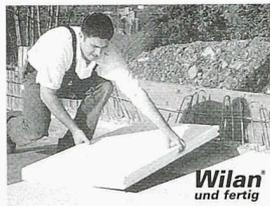
Isolationselemente **einseitig** belegt mit äusserst widerstandsfähigen Fertigdeckschichten aus Kunststoffen, Faserzement oder Holzwerkstoffplatten Für das direkte Einlegen und einbetonieren in Deckenschalungen oder für nachträgliche Montagen.
