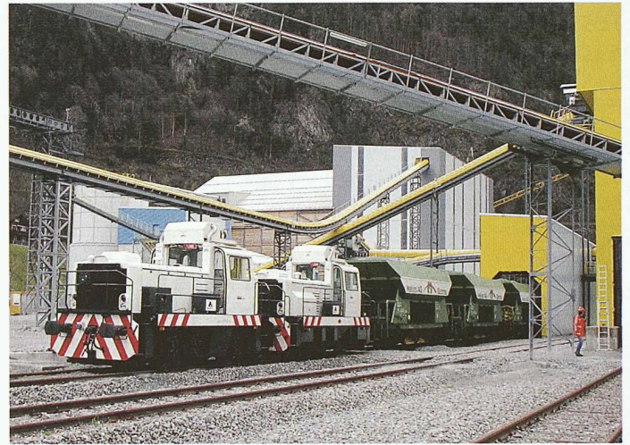
Nicht nur der eigentliche Tunnelbau, auch die Logistik ist eine beachtliche Leistung (Bild: Alp Transit Gotthard)
