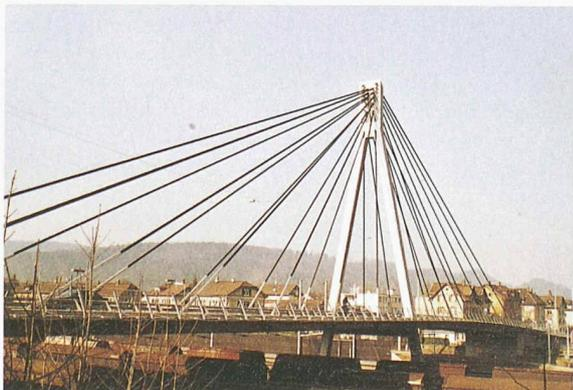
Bei der Storchenturmbrücke, die den Rangierbahnhof Winterthur überspannt, wurden erstmals versuchsweise zwei Schrägseile aus Kohlefasern anstatt aus Stahl eingebaut (Bild: pps)
