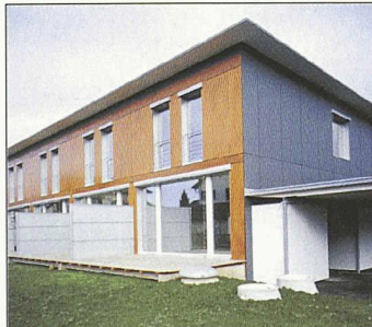
Minergie- und Passivhausbauweise
