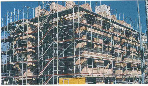
Mauerwerksbau mit problematischem Erdbebennachweis
