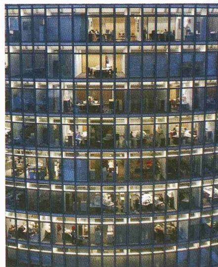
Digitalisierte Arbeitswelt: Abschalten statt Standby-Modus lautet die Stromspar-Devis (Bild: Bürogebäude am Potsdamer Platz in Berlin / key)
