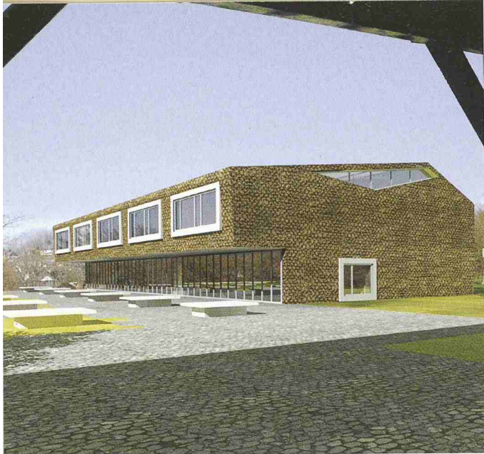
Spezielle Dachform mit zusätzlichen Oblichtern für die Schulräume. Davor die Oblichter für die Turnhalle (1. Rang, B. E. R. G. Architekten)
