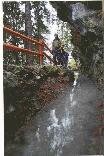
Bisse de Saxon, Abschnitt des renovierten Teilstücks (Bild: key)
