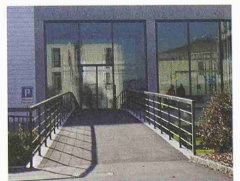
Der hindernisfreie Eingang der Endress & Hauser Flowtec (Architekten: Burckhardt + Partner)
