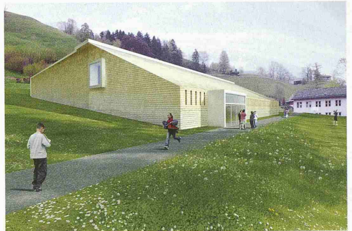
Die Sporthalle für die Toggenburger Orte Nesslau und Krummenau als hölzernes «Objekt» (1. Rang, Christian Bühlmann und Imre Bartal)
