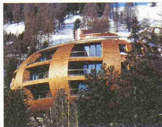
Holz als Fassadenmaterial: Die Chesa Futura in St. Moritz von Norman Foster ist mit Lärchenholzschindeln verkleidet (Bild: Team Chesa Futura/Lignum)
