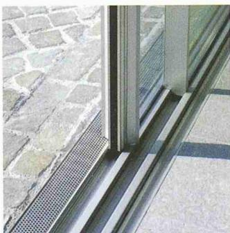
Rinne. Dank konsequenter Trennung von Innen- und Aussenschalen wird ein guter Rahmen-Isolationswert erreicht (U-Wert gerechnet 2.1 W/m<sup>2</sup>K). Aus der kleinen Rahmenfläche ergeben sich über das ganze Fenster gerechnet Spitzenwerte.
