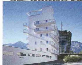
K. Schmalhofer, O. Nadel: Ama-lienbad (1923–26); F. Tamm: Flaktürme (1942–44); L. Welzenbacher: Turmhotel Seeber (1930–31), mit Parkhotel von Henke und Schreieck (2003; Bilder: azw)
