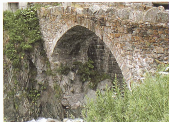
Pont à Wassen, Uri
