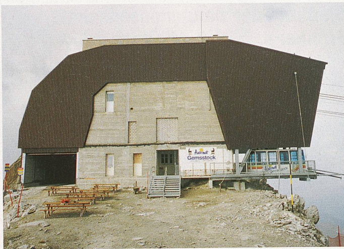
Andermatt UR, seit Jahrhunderten Alpentransitstation, seit 150 Jahren Militärgarnison, seit 100 Jahren Wintersportort, hat mehr Baukultur zu bieten, als es selber weiss. Die durchaus aktuellen Formen der Gemstock-Bahn-Bergstation etwa stammen von 1963 (Bild: Peter Regli)
