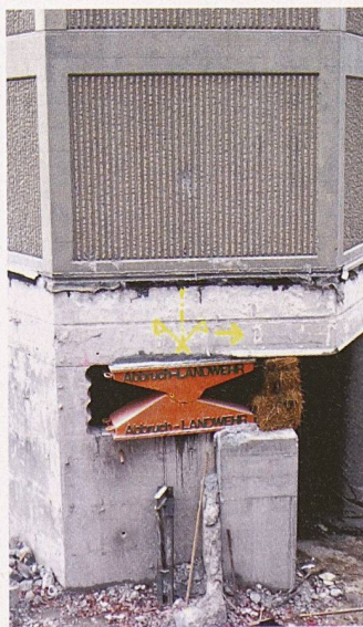
Eines der 2 Stahlkippgelenke im Turmfuss, links Beton-Restquerschnitt
