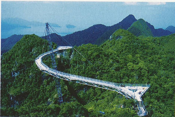
Prix Acier: Aussichtsbrücke in Malaysia. Lediglich ein Pylon trägt die 120 m spannende, geschwungene Brücke (Bild: SZS)
