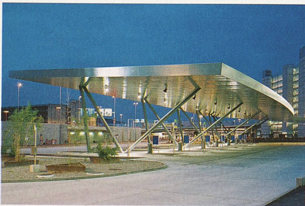
Prix Acier: Bushofüberdachung am Flughafen Zürich. Stahl und lichtdurchlässige Dachelemente aus Fiberglas (Bild: Ralph Bensberg)
