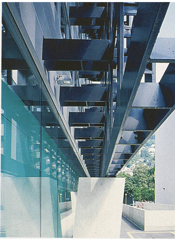
Europäischer Stahlbaupreis: Geschäftshaus in Locarno. Die Geschosdecken sind an der aussen liegenden Tragstruktur aufgehängt (Bild: Hans Ege)
