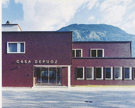
Kategorie Bausanierung: Casa Depuoz, Trun (curschellas + gasser)
