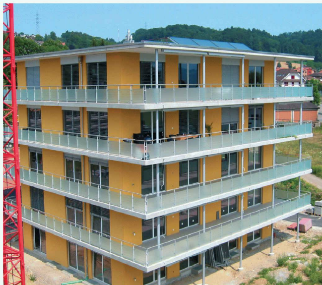
Zellfeldpark - Schenkon am Sempachersee – zukunftsweisende Wohn- und Arbeitsimmobilie, 2 x 6 Mehrfamilienhäuser mit Tiefgarage, Thermowände, Elementdecken –
