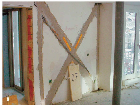
8 Aussteifung einer bestehenden tragenden Mauerwerkwand im 4. Obergeschoss des Westanbaus mit kreuzförmig angeordneten Klebbewehrungen (Bilder: Emch + Berger AG)
