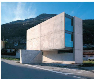
Guidotti &amp; Guidotti, Casa Grossi, Monte Carasso (Bild: Filippo Simonetti)
