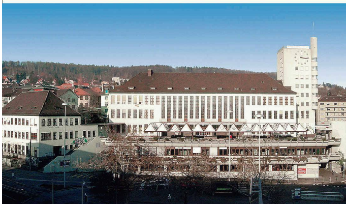
Das Kirchengemeindehaus Wipkingen in Zürich, erbaut 1931 von Vogelsanger und Maurer, soll saniert werden. Der Schutzzumfang des Ensembles aus Turm, Saal und Kinderkrippe ist unklar (Bild: pd)
