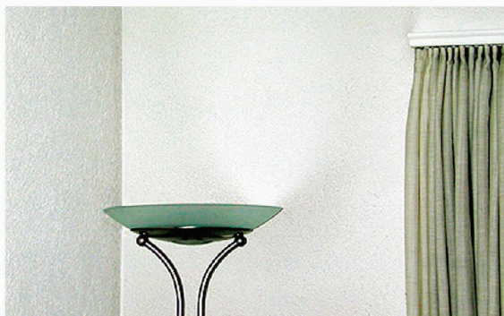
Typisches Schadenbild in einer Wohnung. Die schwarzen Ablagerungen sind deutlich sichtbar (Bild: Empa)
