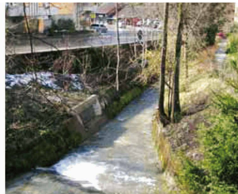
Hochwasserentsorgung (Bild: Entsorgungsamt Stadt St. Gallen)
