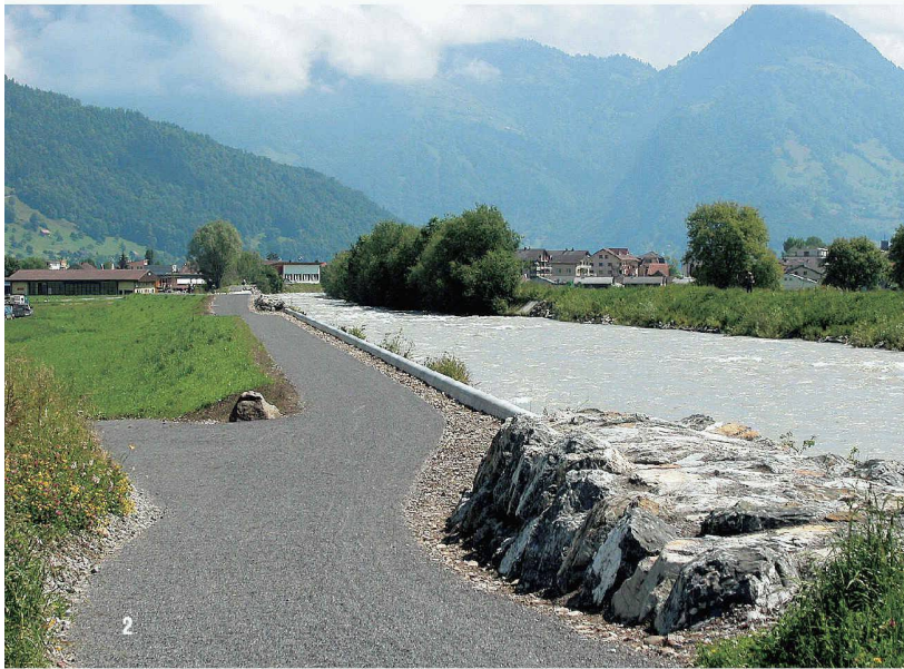
2 Hochwasserentlastung mit Streichwehrkante vor Buochs (Bilder: Tiefbauamt Nidwalden)
