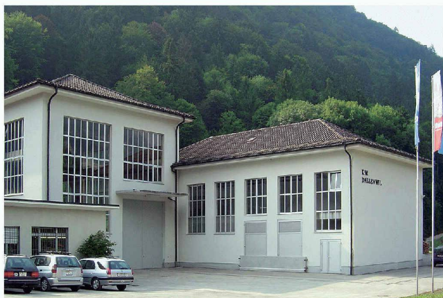
Bei Hochwasser an der Engelberger Aa wird das Kraftwerk Dallenwil durch zusätzlichen lokalen Objektschutz gesichert (Bild: Hans Peter Willi)
