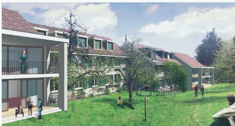
Die neuen angebauten Loggien sind ein Teil der Erneuerung des Weissenheims in Bern (1. Rang, Stucky Schneebeli Architekten)
