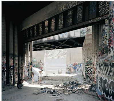
Auch eine Perspektive – unter einer Eisenbahnbrücke in Los Angeles (Bild: Bas Princen)
