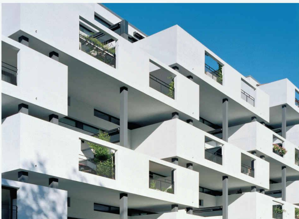
Ausgezeichnet wurden die Wohnüberbauung Hagenbuchrain Zürich (oben links), das Gemeindeverwaltungszentrum Affoltern am Albis (oben rechts) und die Wohnüberbauung Paul-Clairmont-Strasse Zürich (unten; Bilder: Andrea Helbling)
