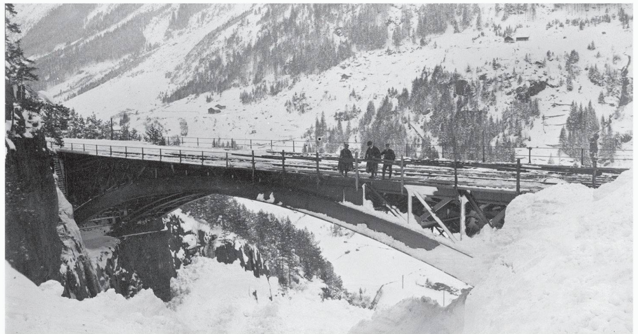
11 Die Rorbachbrücke nach dem Niedergang der Rortallawine am 19. und 22. April 1917 vom Widerlager Süd aus gesehen. Über dem oberwasserseitigen Bogenträger sind die zwischen 1909 und 1920 als Verstärkung eingebauten Diagonalstreben erkennbar
