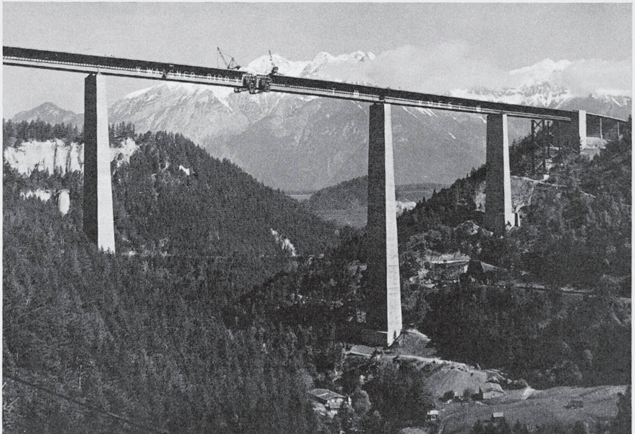
Bild 31. Die Europabrücke zwischen Innsbruck und Brennerpass erhielt eine Fahrbahnsicherung gemäss Bild 30
