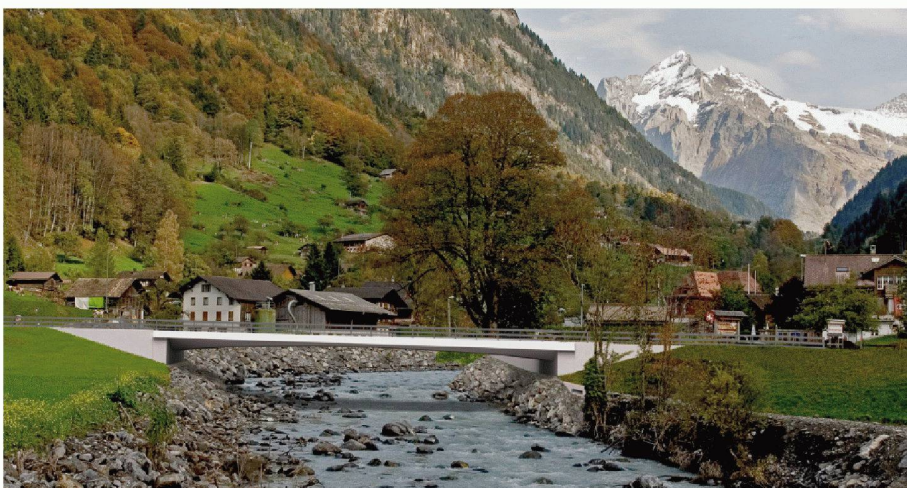
Die klaren Linien und die schlanke Erscheinung der Brücke von Bänziger Partner Ingenieure und Eduard Imhof fügen sich gut in die Umgebung ein
