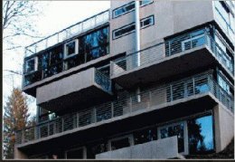
DEFH Bergstrasse, Zürich
