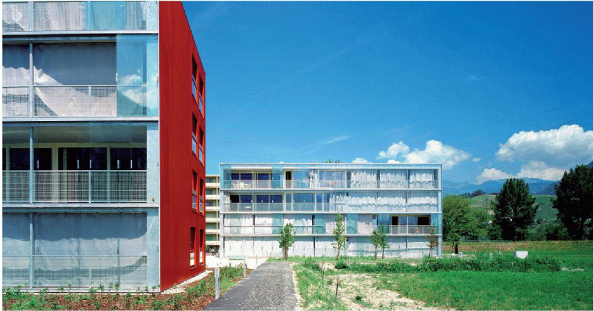
Prämierte Mehrfamilienhäuser in St-Maurice der Architekten Bonnard und Woeffray und der Ingenieure Kurmann & Cretton (Bilder: Kurmann & Cretton)
