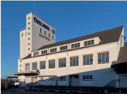
01 Eines der Bauwerke im Faltblatt «Baukultur entdecken – Rheinfelden»: das 1930 erbaute Silogebäude der ehemaligen Brauerei Salmenbräu (später Cardinal) des Architekten Heinrich A. Liebetrau (Bild: Henri Leuzinger)
