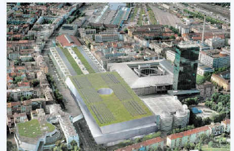
02 Die unter Schutz gestellte Rundhofhalle von Hans Hofmann von 1954. Im Hintergrund der zum Abbruch freigegebene Kopfbau der Messehalle 1 von Hermann Herter von 1926 (Bild: SHS)
