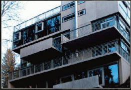
DEFH Bergstrasse, Zürich
